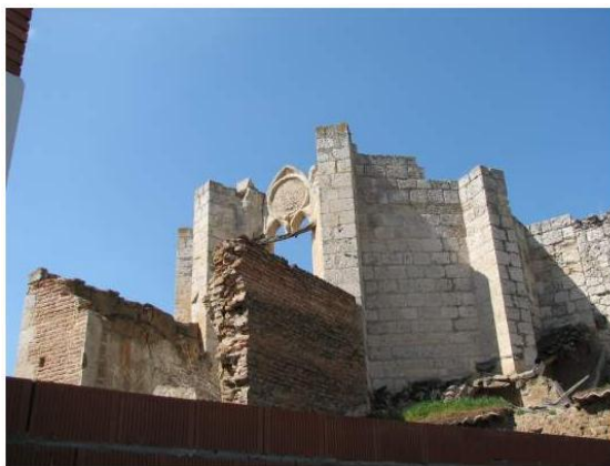
Actual estado del convento de San Francisco de Peñafiel
