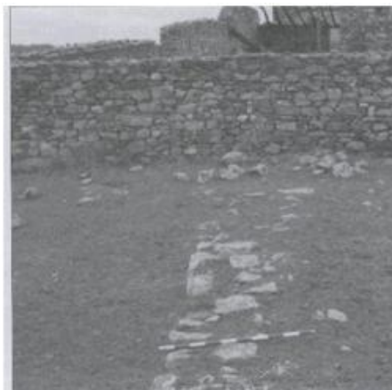
Fig. 10. Cimientos de muro al este
