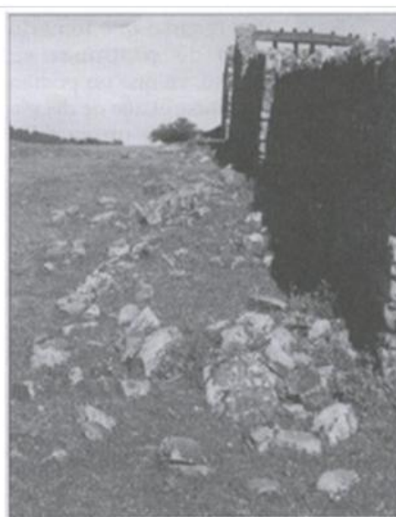
Fig. 8. Cimientos del muro sur
